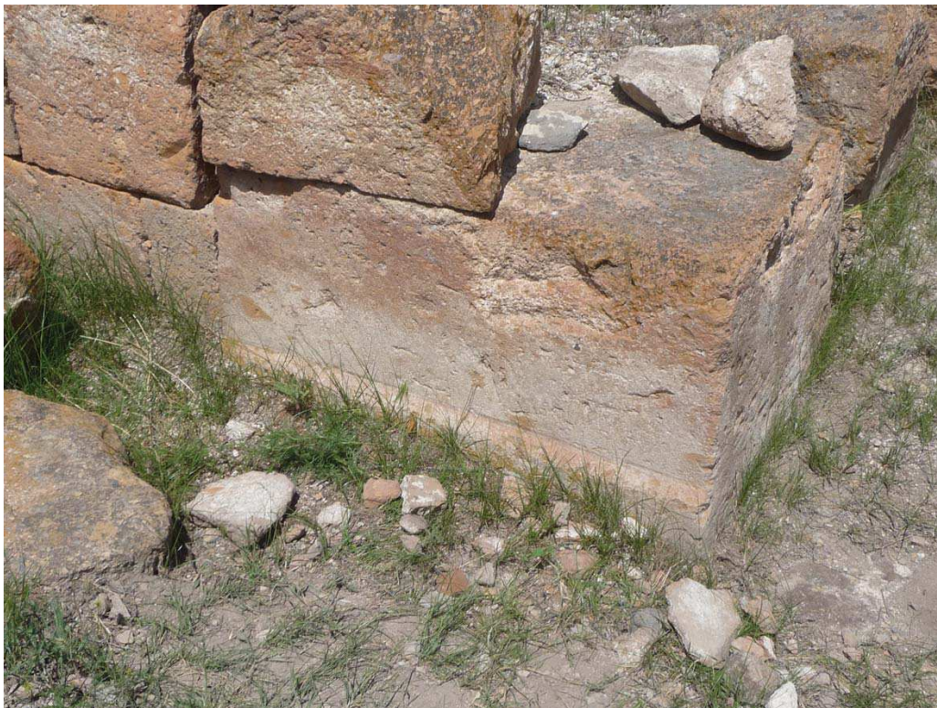
Fig. 54 – Ereruyk. Enceinte orientale. Saillant absidal (ou exèdre) sud SAL 1510. Angle sud-ouest vu du nord-ouest. Cliché : A. Hartmann-Virnich (LA3M, 2014).
