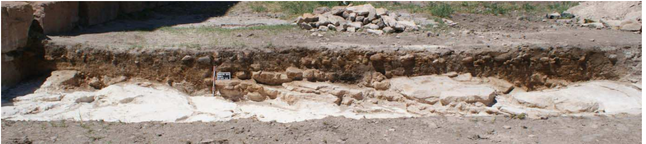
Fig. 93 – Vue de la coupe nord de la partie occidentale du sondage 6 Cliché : F. Krähenbühl (LA3M, 2014).
