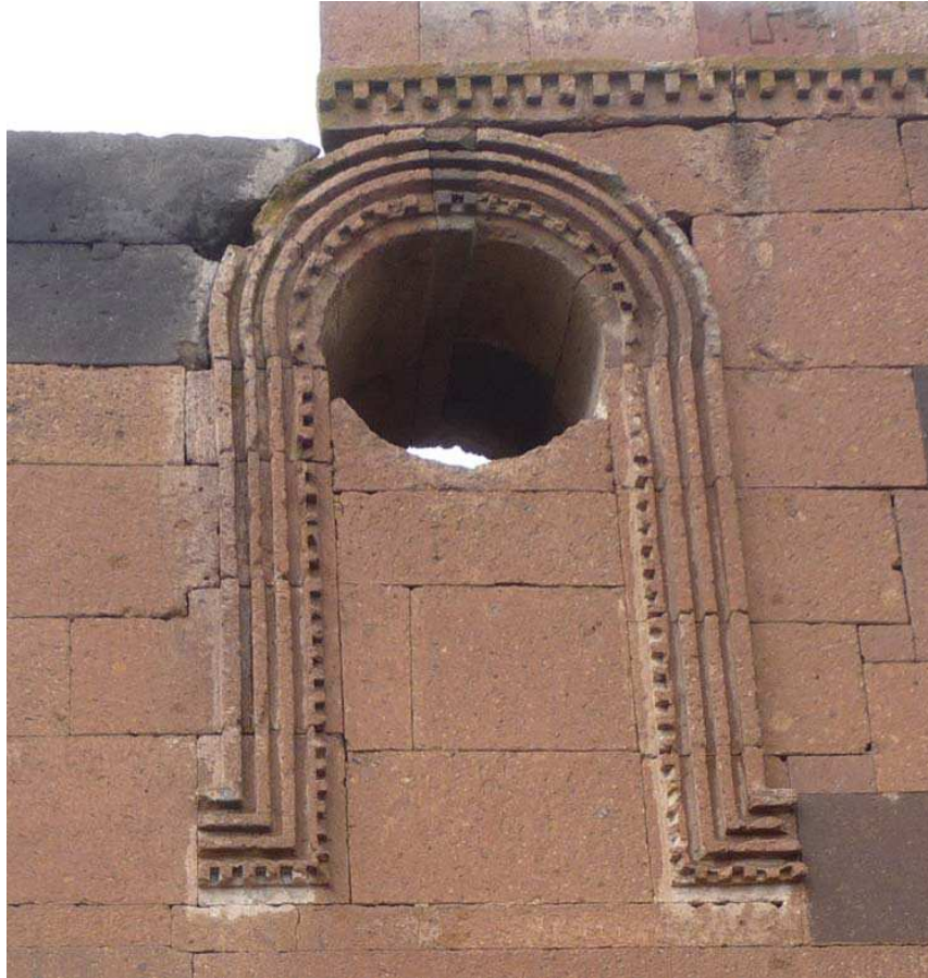
Fig. 29 – Ereruyk. Basilique, façade sud. Fenêtre de la travée occidentale. Cliché : A. Hartmann-Virnich (LA3M, 2014).
