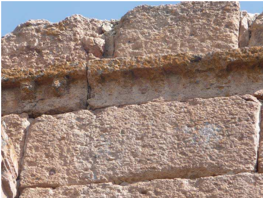
Fig. 30 – Ereruyk. Basilique, façade sud. Bande denticulée en haut de la travée orientale. Cliché : A. Hartmann-Virnich (LA3M, 2014).
