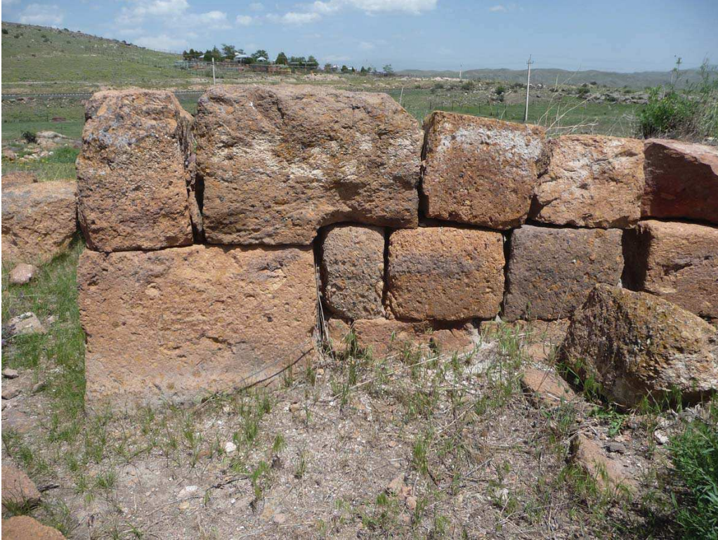
Fig. 53 – Ereruyk. Enceinte orientale. Saillant absidal (ou exèdre) sud SAL 1510. Flanc nord vu du sud. Cliché : A. Hartmann-Virnich (LA3M, 2014).
