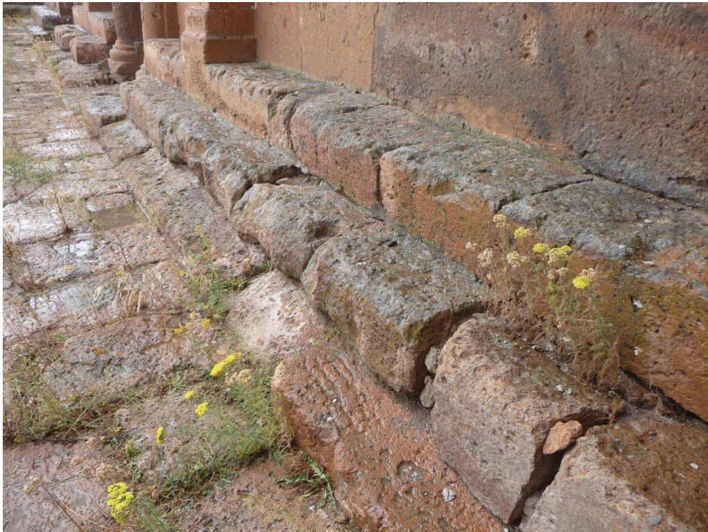
Fig. 26 – Ereruyk. Basilique, façade sud, extrémité est. Gradins au pied du mur gouttereau. Cliché : A. Hartmann-Virnich (LA3M, 2014).
