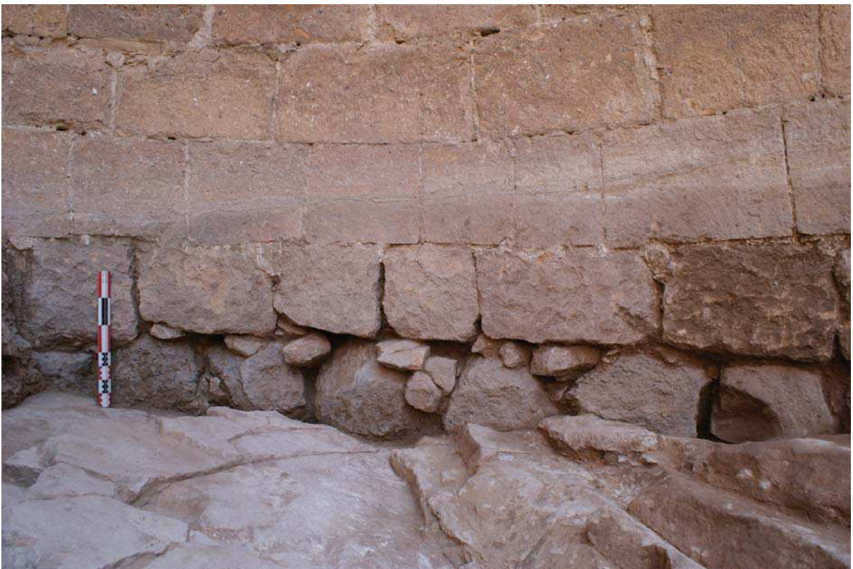
Fig. 66 – Sondage 12, détail de la fondation de l'abside Cliché : D. Martinez (LA3M, 2014).
