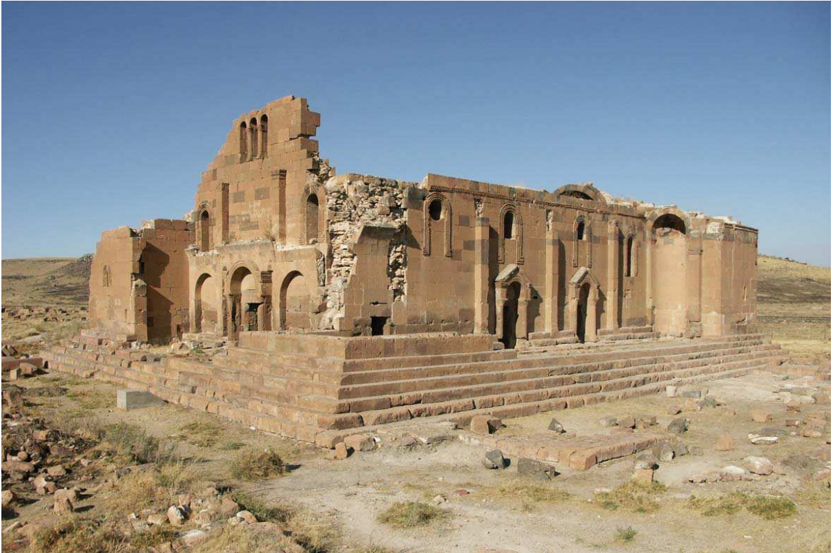
Fig. 4 – Ereruyk. Basilique. Vue générale du sud-ouest. Cliché : P. Donabédian (LA3M, 2011).
