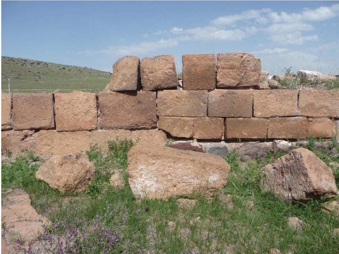
Fig. 41 – Ereruyk. Enceinte orientale. Face ouest du mur MUR 1200. Cliché : A. Hartmann-Virnich (LA3M, 2014).
