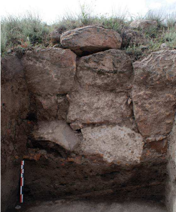
Fig. 112 - Vue vers le sud du mur de barrage de la phase B Cliché : C. Jorda (LA3M, 2014)
