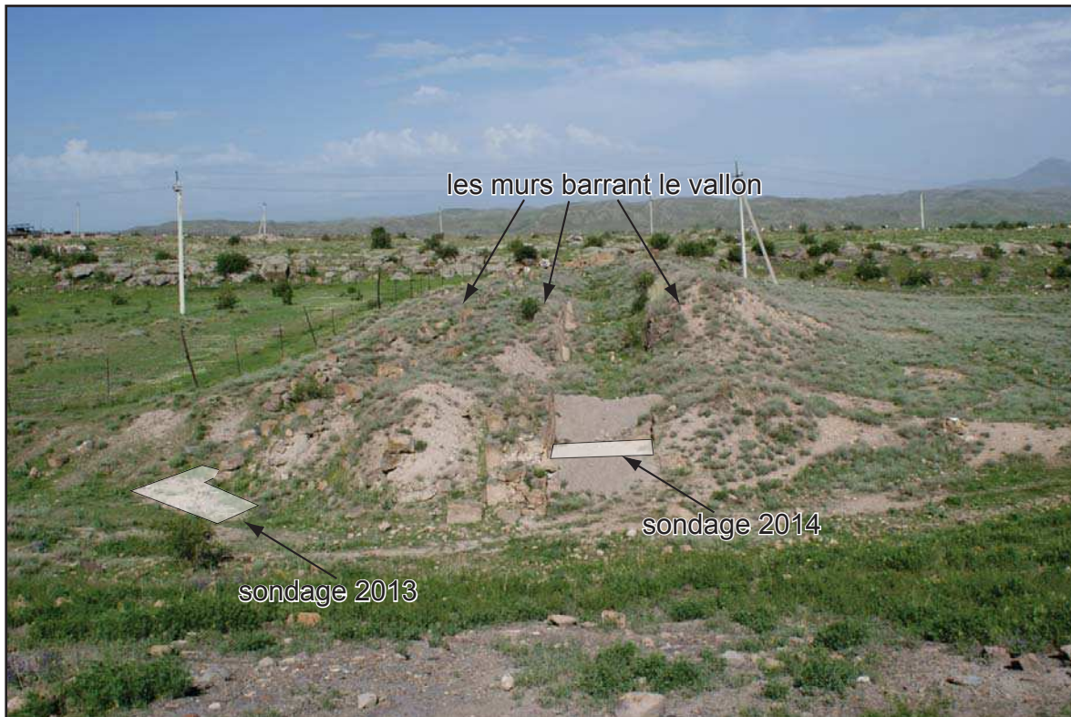
Fig. 110 - Vue générale du dispositif de barrage depuis l'ouest Cliché et DAO : C. Jorda (LA3M, 2014)
