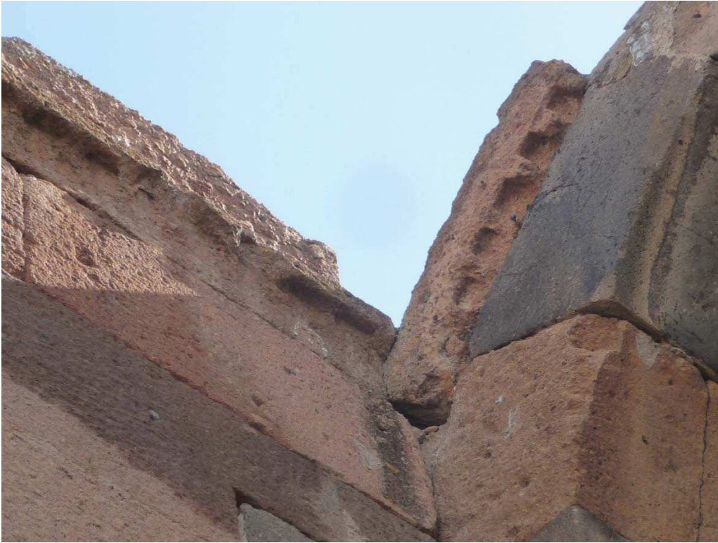
Fig. 31 – Ereruyk. Basilique, façade sud. Jonction du haut du mur gouttereau sud et de l'arc triomphal de l'absidiole sud-est.
