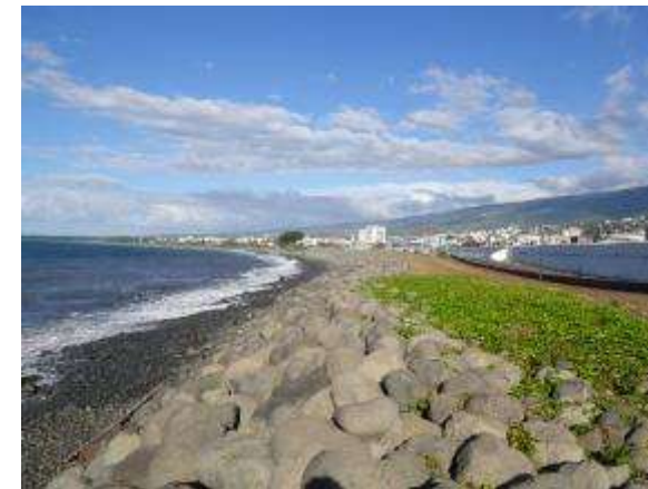
Enrochement sur le littoral de Saint-Denis
