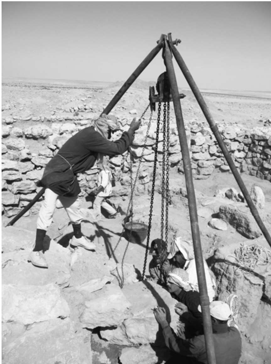
Fig. 30. Reconstruction partielle d'une portion de mur effondrée à l'aide d'une chèvre.
