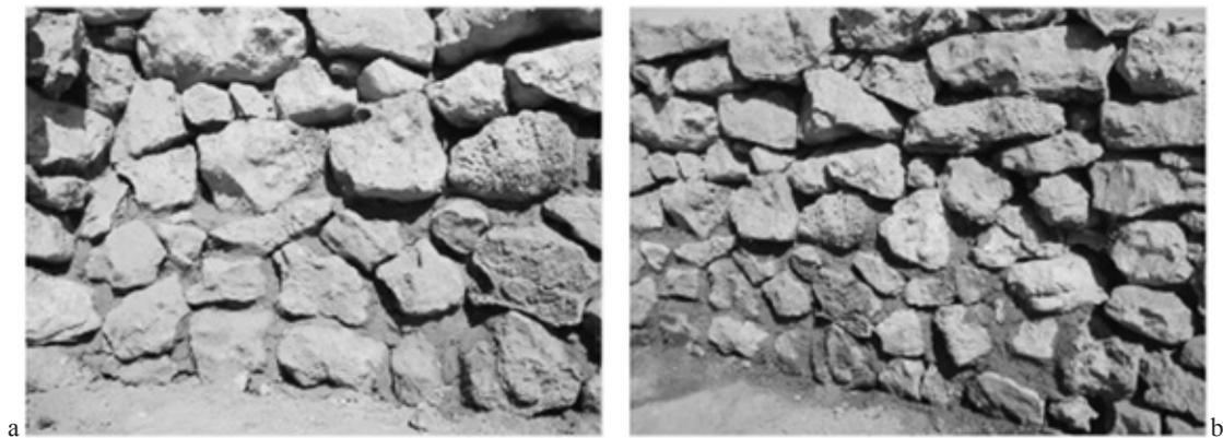
Fig. 31a. Un mur d'un temple d'un état antérieur, consolidé avec du ciment;
