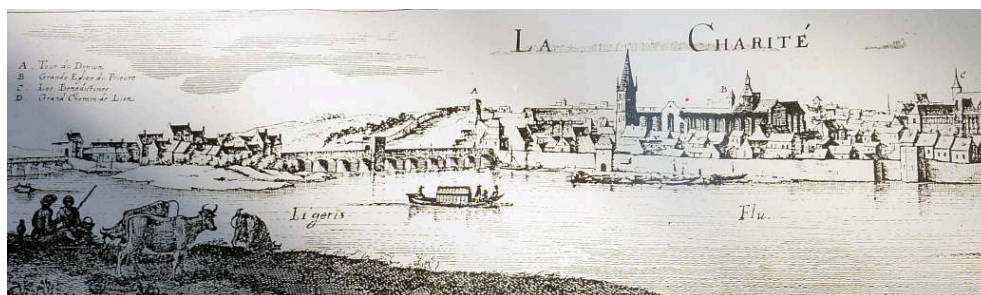
Figure 9. Détail de la gravure de Matthäus Merian, datée de 1640. On voit l'île du Faubourg, les remparts bordant le fleuve et les différents ouvrages défensifs destinés à contrôler l'accès aux ponts
