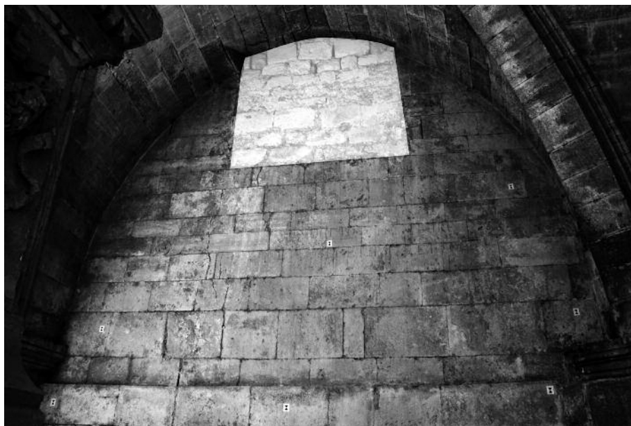
Fig. 25 - Saint-Gilles-du-Gard, crypte, mur occidental du collatéral nord, baie obturée par un appareil irrégulier.
