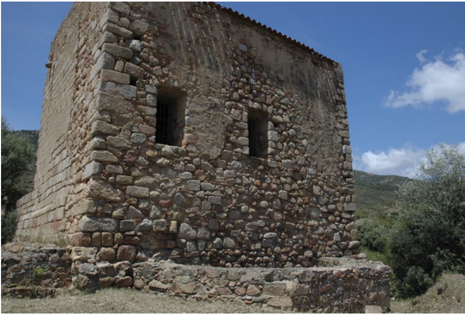
fig. 3 – Vue de la façade orientale de la cathédrale. Le mur oriental, percé de deux fenêtres, a été érigé entre 1728 et 1730. L’abside médiévale a complètement disparue mais on remarque les vestiges de l’abside à trois pans de la cathédrale de VI e siècle.
