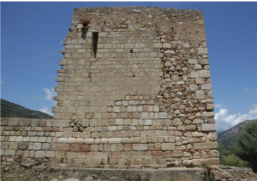
fig. 6 – Vue de la partie orientale de la façade sud. Les différentes phases de construction et de restauration sont clairement visibles. On remarque aussi la haute plinthe biseauté, partiellement restaurée dans les années 1980.
