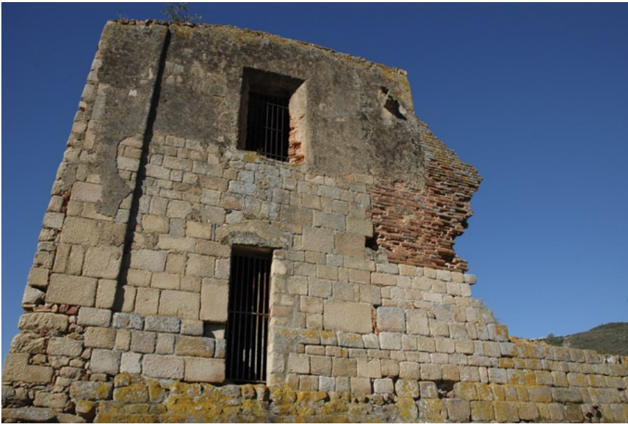
fig. 5 – Vue de la partie orientale de la façade nord. On distingue très clairement le pilastre d'angle, la porte romane surmontée d'une grande fenêtre plus tardive, ainsi que les différentes reprises des maçonneries à droite du chaînage d'attente 99.
