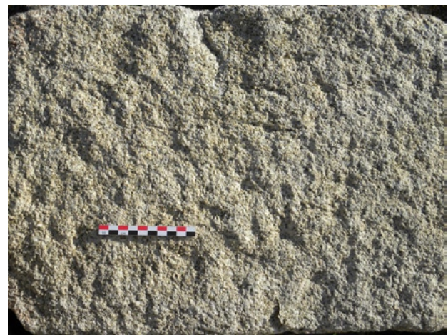
fig. 13 – Détail d'un bloc de parement en granite gris. On remarque les traces d'impacts de l'outil.
