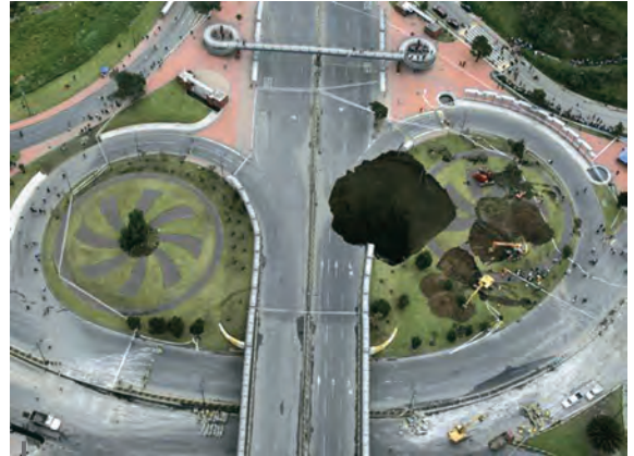
Figura 2 – Vista aérea del hundimiento «El Trébol»
