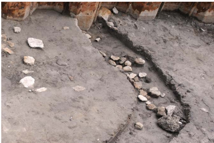
■ Fig. 80 : Vue de détail des calages de poteau présents au niveau de l'abside orientale de l'UNF139, depuis le sud.
