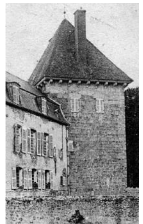
Fig. 3 : tour maîtresse de La Roche-en-Brenil. (CPA).
