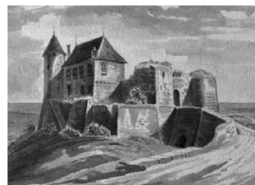
Fig. 16 : le château en 1868, avec à gauche la « tour du Phare » en cours de démolition. Dessin Chandelux, bibliothèque de la société éduenne. Grand format p. 224 et 229.
