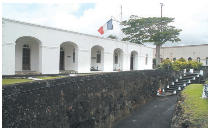
Passage Dauphine, creusé dans la roche
