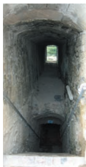
Accès aux canonnières du cavalier
