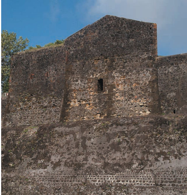
La casemate Gémosat se distingue bien sur le rempart.
