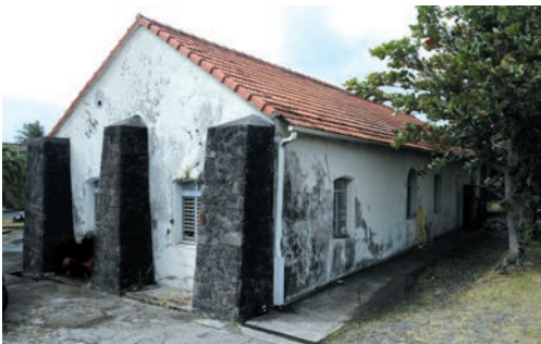
Bâtiment des Forges et ses contreforts
