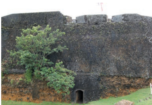
Vue du socle rocheux du cavalier et du tunnel d'accès
