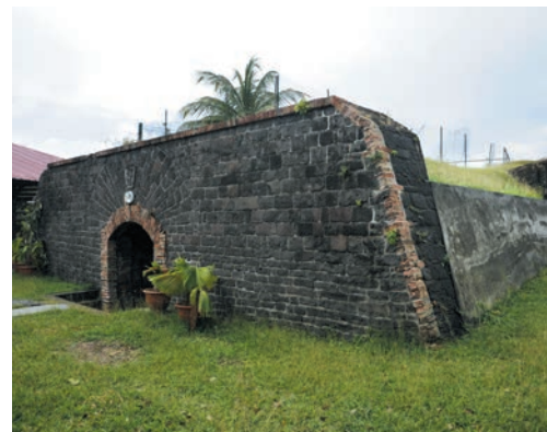
La casemate d'Orange édifée en 1877
