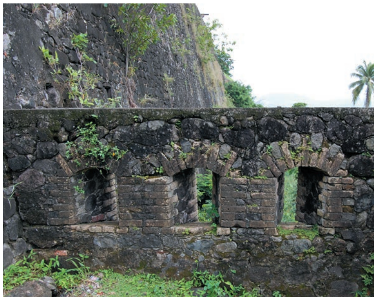
Parapet à l'extrémité du bastion Sainte-Marthe dans l'axe du flanc ouest
