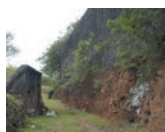
Le ressaut de roche sert de sousbassement au rempart Pelletier.
