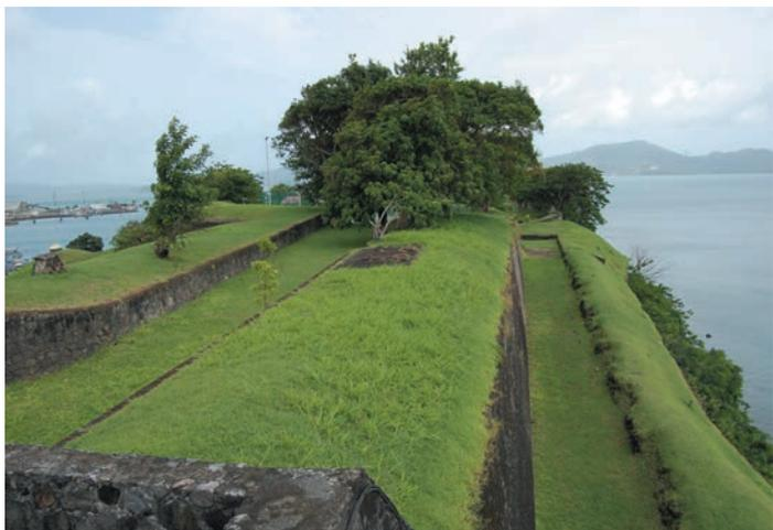
Le front ouest du cavalier (bastion 13) présente une batterie à barbette avec un parapet pourvu d'une masse couvrante. Le long de ce front – qui représente un second niveau de défense au-dessus de l'étage inférieur face à la baie des Flamands – subsistent différentes traces d'installations d'artillerie. On y voit les vestiges en « Y » des emplacements de canons de 75 antiaériens
