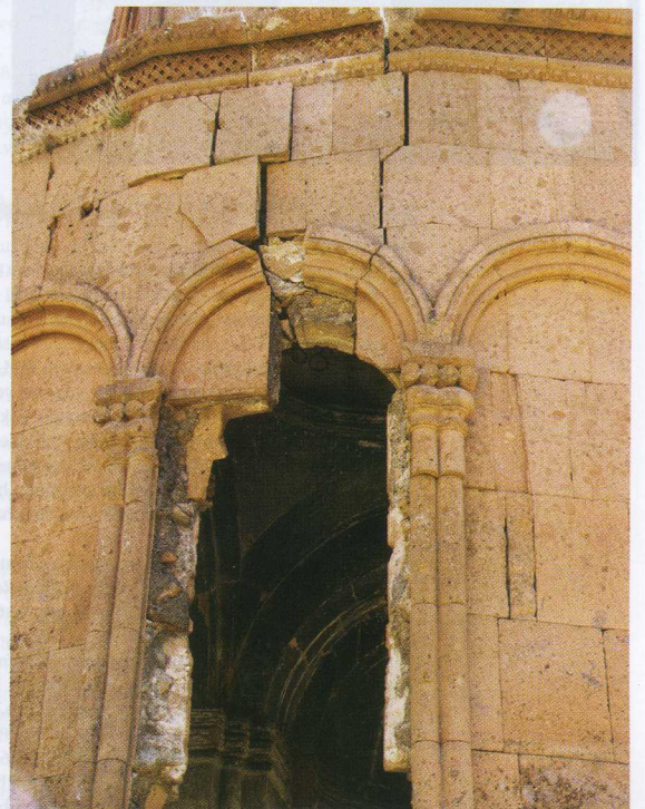
Foto 40. Khıdzgonk. Surp Sarkis Kilisesi, batı cephesinin merkezi, 2013.
