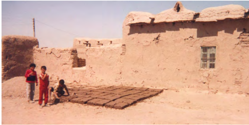
Fig. 9 : Briques crues séchées au soleil, Tell Leilan, Syrie du nord-est (photo X. Faivre).
