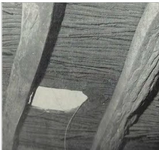
Fig. 1 : Marūza et plafond végétal enduit de mouna dans une maison de la province de Charqia D'après Rizqallah et Rizqallah 1978 : pl. I.
