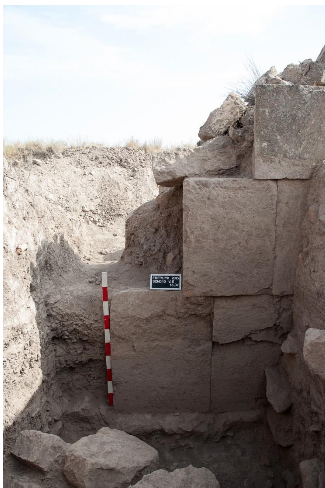
Fig. 115 et 116 – Ereruyk. Stratigraphie vue vers le sud du sondage SD 15 avec le mur intermédiaire du barrage (M 140) intégralement détruit dans sa partie est. Photos de F. Krähenbühl (LA3M, 2015).
