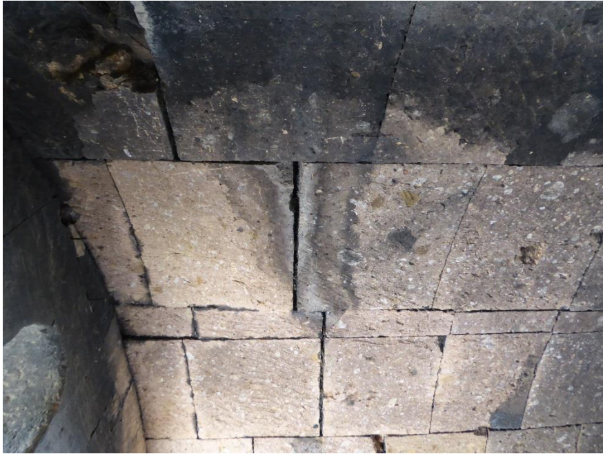
Fig. 59 – Ereruyk. « Mausolée » dans le vallon. Détail de la voûte de la travée occidentale. Photo d'A. Hartmann-Virnich (LA3M, 2015).
