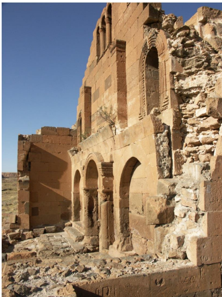
Fig. 16 – Ereruyk. Basilique. Façade ouest, maçonnerie adossée pour l'adjonction d'un nouveau portique, abaissé. Photo de P. Donabédian (LA3M, 2013).
