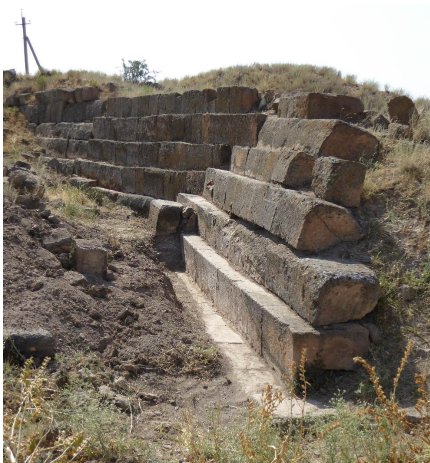
Fig. 67 – Ereruyk. Murs transversaux au vallon au sud du site. Vestiges du mur à gradins MUR 4100-4200-4300, vus vers l’est. Photo d’A. Hartmann-Virnich (LA3M, 2015).
