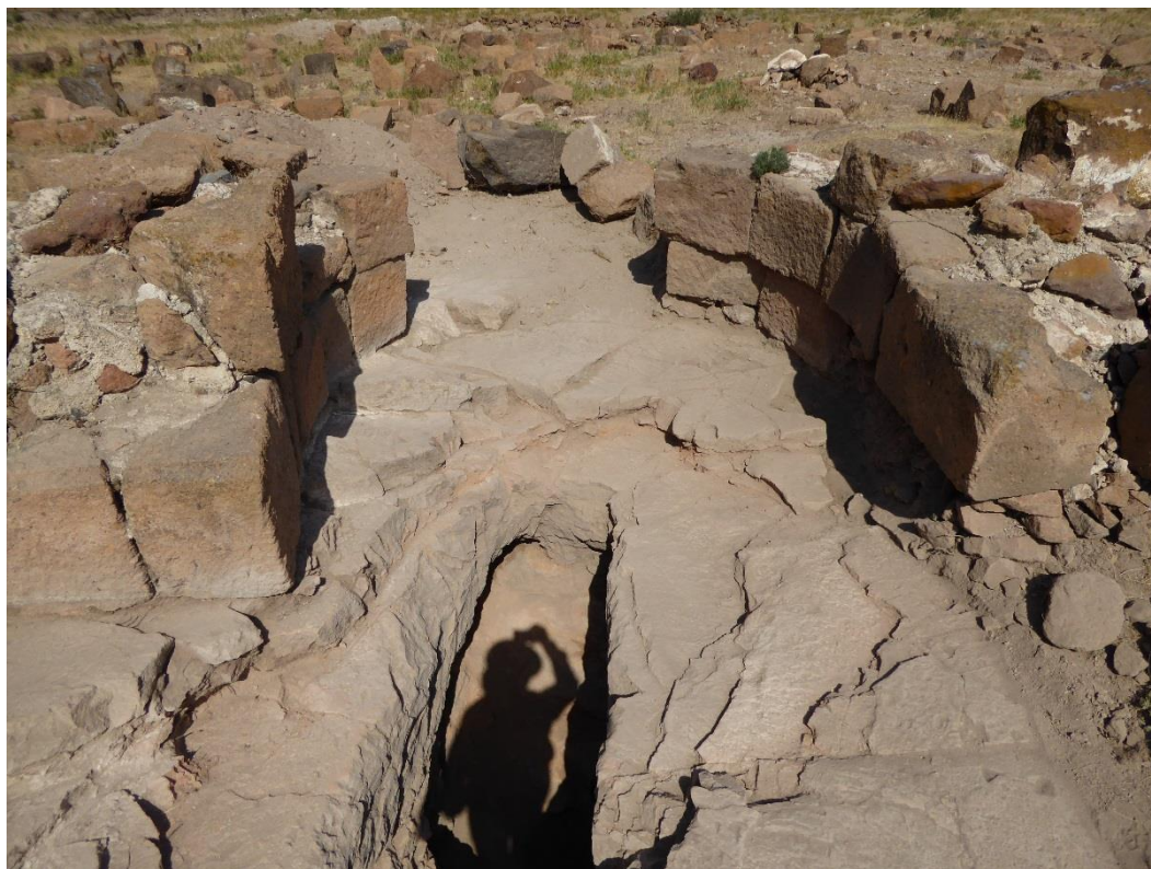
Fig. 47 – Ereruyk. « Enceinte » orientale. Saillant SAL 1110. Intérieur du saillant après dégagement du substrat et de la cavité au centre de la structure bâtie. Photo d'A. Hartmann-Virnich (LA3M, 2015).
