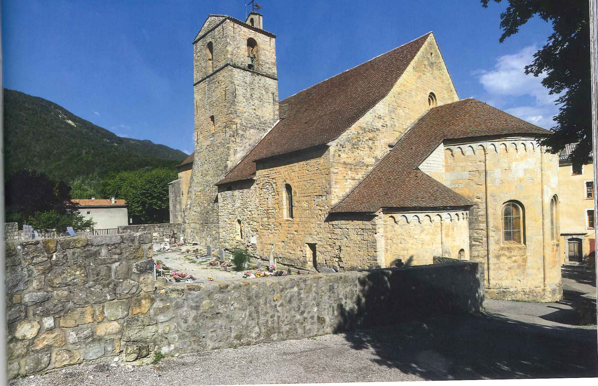
L'architecture de la cathédrale de Senez se rapproche de celle des églises des monastères chalaisiens édifiés dans les Alpes du Sud à partir de la seconde moitié du XII e siècle : Boscodon (Hautes-Alpes), Valbonne (Alpes-Maritimes) ou Lure (Alpes-de-Haute-Provence). Au-delà de la grande sobriété du décor, c'est leur agencement général qui les rapproche : nef unique, faux-transept et murs gouttereaux nus.
