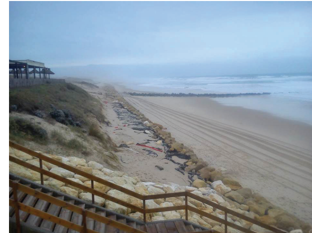
Fig. 3 – Risque naturel et érosion de la dune : l'effondrement après le passage de la dépression « Hercule »
