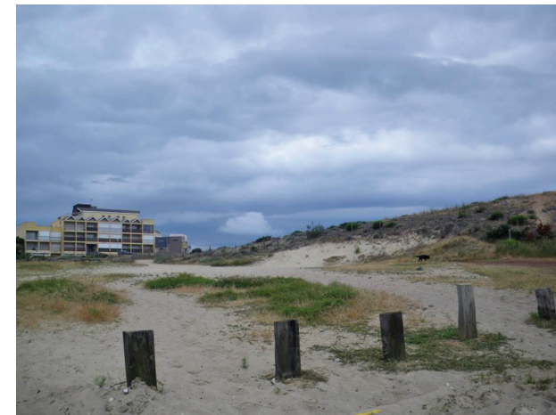
Fig. 4 – Discontinuité entre espace dunaire sensible et construction sur le front de mer
