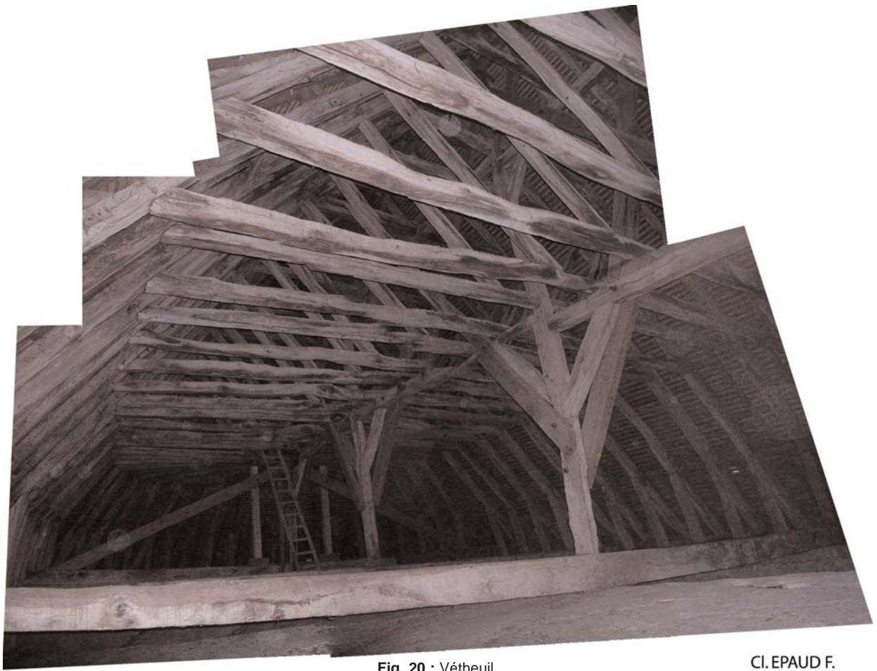
Fig. 20 : Vétheuil. Charpente du chœur, 1210-1212d.
