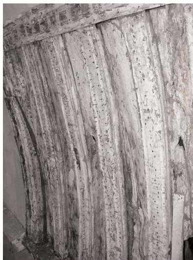
Fig. 57 : Mesnil-sous-Vienne. Plaque fixée aux cerces moulurées, XVI e s.
