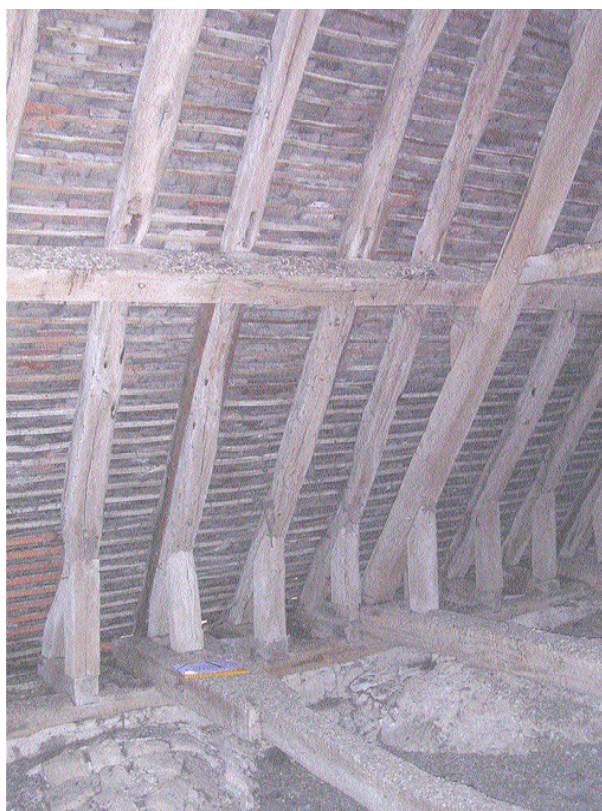
Fig. 13 : Nesles-la-Vallée. Charpente de la nef avec les chevrons d'origine en place (1219d), avec insertion en sous-œuvre des fermes et des pannes.
