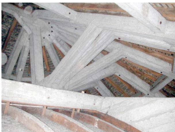
Fig. 59 : Église de Deuil-la-Barre, charpente en béton coulé du chœur, 1950.
