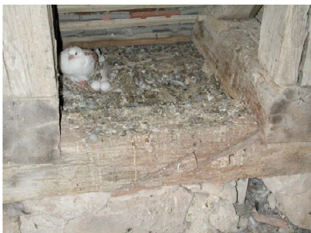
Fig. 17 : Nesles-la-Vallée. Enture crantée des sablières, 1219d.
