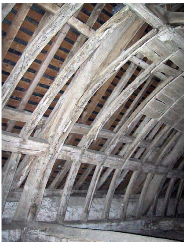
Fig. 53 : Arronville. Vue des cerces courbes assemblés aux liernes.
