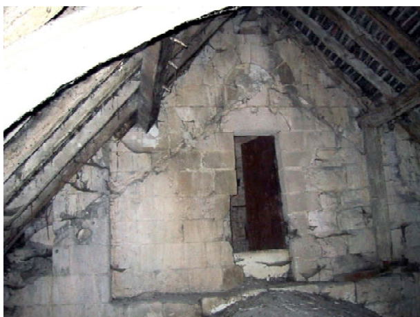
Fig. 7 : Église de Brignancourt. Négatif de la toiture romane de la nef.
