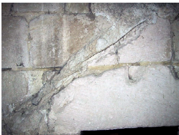
Fig. 8 : Église de Brignancourt. Empreintes des matériaux de couverture de la toiture romane.
