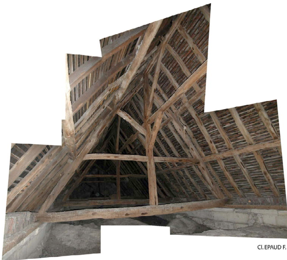
Fig. 45 : Église Saint-Aquilin de Fontenay-en-Paris. Charpente du chœur, milieu du XIII e s.
