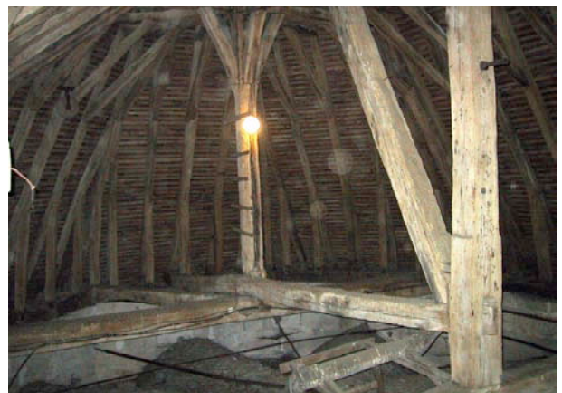
Fig. 31 : Bessancourt. Croupe absidiale avec son dispositif de contrebutement.
