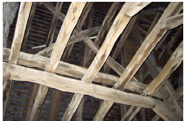
Fig. 30 : Bessancourt. Double liernes et croisée d'écharpes.
