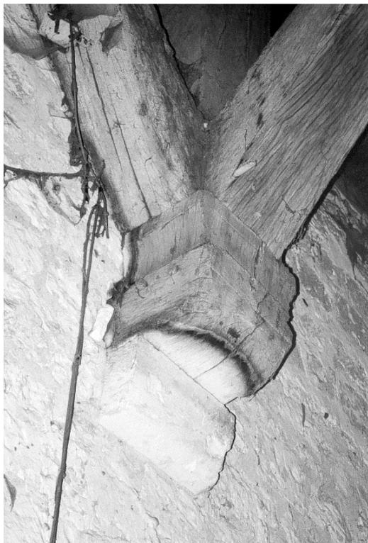
Fig. 9 Assemblages de pied d'une ferme intermédiaire
