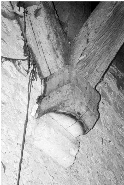
Fig. 8 Sabot en bois sculpté supportant le poteau d'une ferme principale contre le pignon
