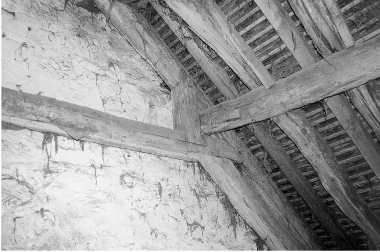
Fig. 7 Assemblages de pied d'une ferme principale
