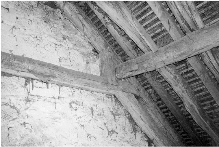
Fig. 7 Assemblages de pied d'une ferme principale
