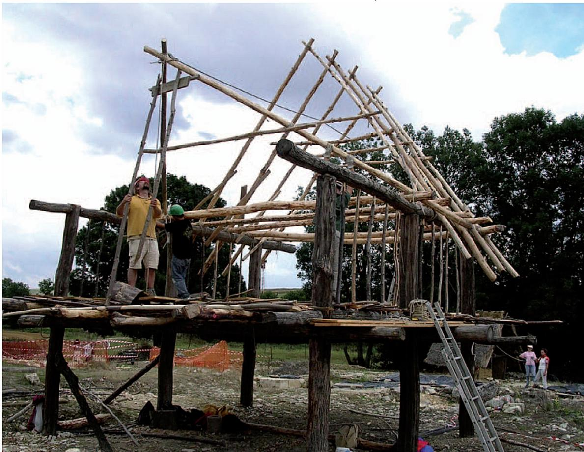
Mise en place des fermes de la toiture depuis le plancher. Cliché F. Épaud, CNRS.
