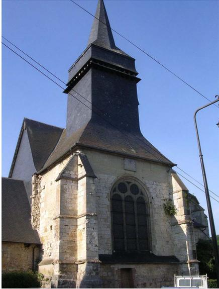
Le clocher est une structure imposante qui a été rajoutée au-dessus de la voûte du croisillon sud un ou deux siècles après la construction de celle-ci, vraisemblablement au XVIIIe siècle. En cela, il s'agit d'une belle prouesse technique puisque de l'intérieur du vaisseau, rien ne permet de distinguer la superstructure qui supporte le clocher, pourtant bien présente sous la voûte.
