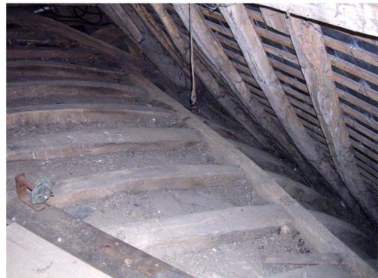
Le lambris d'origine, aujourd'hui disparu et remplacé par un lattis recouvert d'un enduit plâtré, devait être constitué de planchettes clouées en sous-face des cerces. Celles-ci ne présentent aucune rainure sur leur flanc ni moulure en sous-face.
