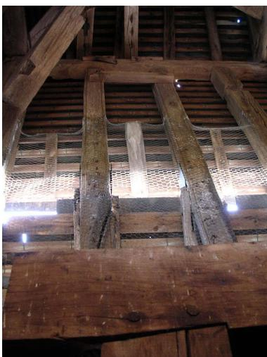
Le colombage des abat-sons est fait d'anciennes cerces rainurées sur les flancs et moulurées, redressées droites. D'autres bois sculptés apparaissent de ci de là, dispersés dans la charpente, avec des mortaises et des entailles vides non réemployées.
