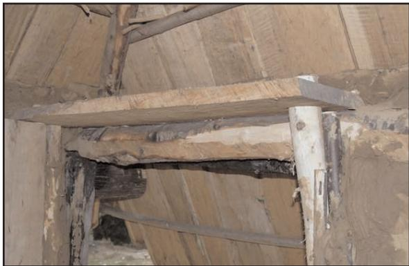
Fig. 13 : Fixation du linteau sur le montant
