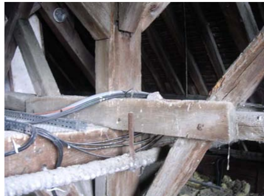
Moises mises en place en 1888 de part et d'autre des poinçons et des liernes
