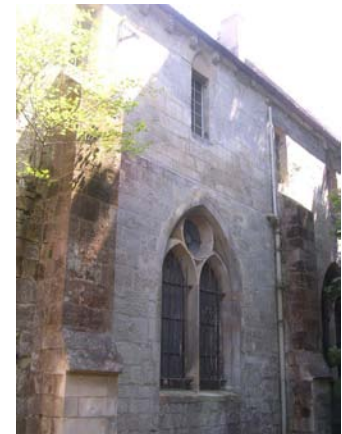
Baies restaurées du XIIIe siècle
