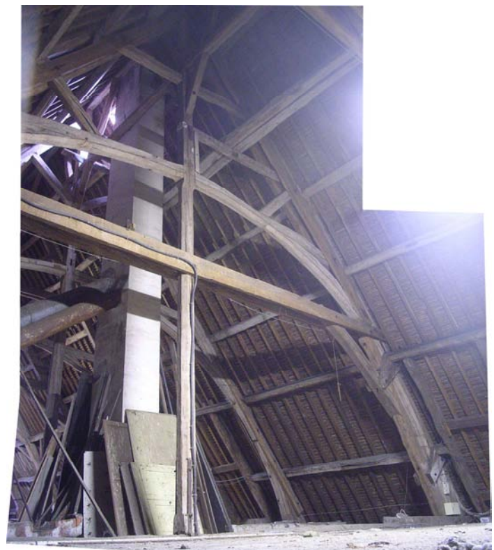
Aisselier courbe avec ses rainures latérales pour l'insertion du lambris
