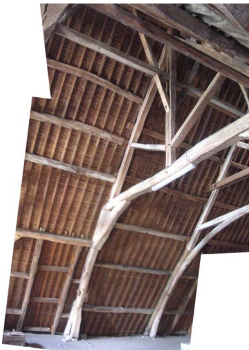
Raccord différencié des pannes témoignant de deux campagnes de construction
