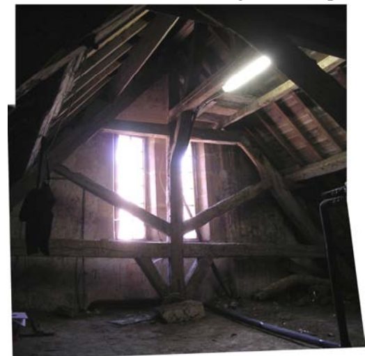
Ferme complète placée contre le pignon oriental
