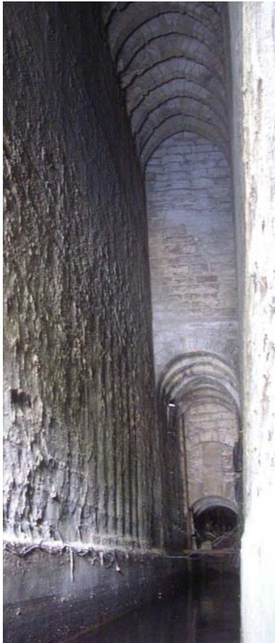
Canal des latrines de l'abbaye de Maubuisson avec l'usure contre le mur gauche des excréments à la verticale des sièges entre chaque arcade
