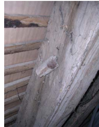
Rainure creusée dans le pignon est pour l'insertion des planchettes du lambris
