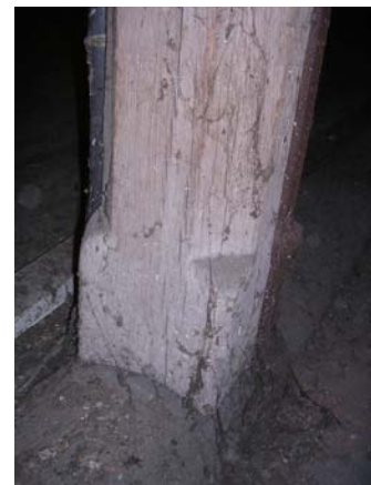
Tête et pied de poinçon. Les arêtes sont simplement chanfreinées, sans moulure ni peinture.
