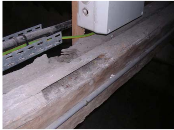
Poinçon de croupe en réemploi avec mortaises aux angles pour des faux entrants d'arêtiers
