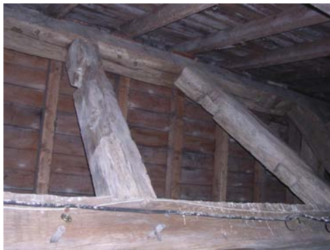
Sablières en réemploi
