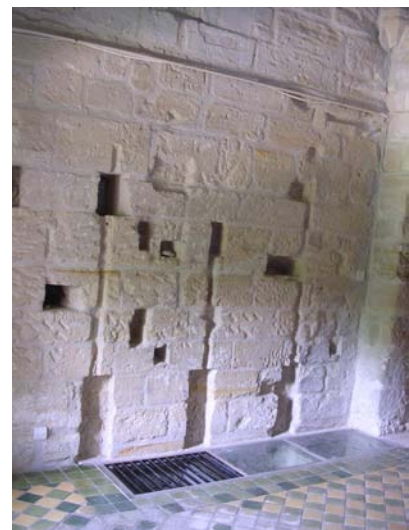
Négatifs des sièges en bois des latrines au-dessus du canal, abbaye de Maubuisson
