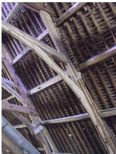
Aisselier courbe avec ses rainures latérales pour l'insertion du lambris
