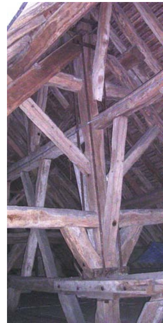
Poinçon "descendu" de 8 cm, renforcé par des atèles en métal, mentionné en 1888
