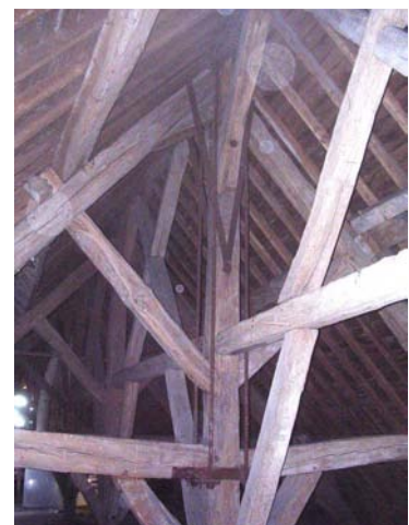
Suspentes renforçant la traction du poinçon
