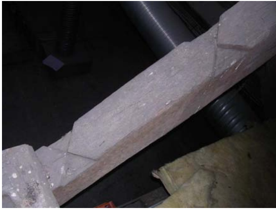
Sablère en réemploi avec ses entailles à double queue d'aronde pour l'assemblage des blochets des fermes secondaires
