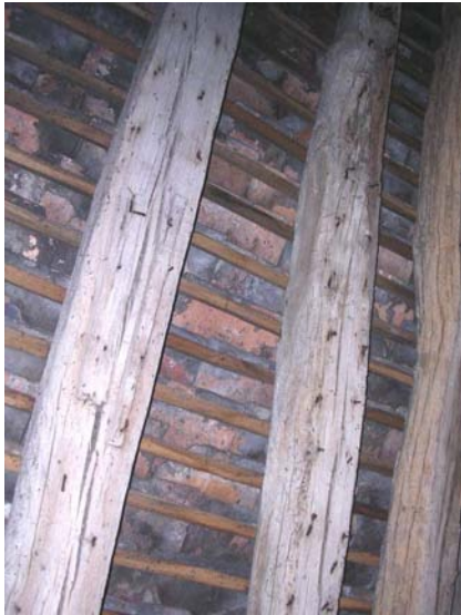
Négatif du lattis de couverture du XIII e siècle sur des chevrons en réemploi
