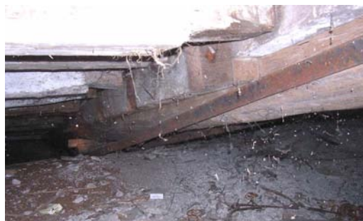
Tirants en W sous-tendant l'entrait sous le plancher de l'ancien dortoir
