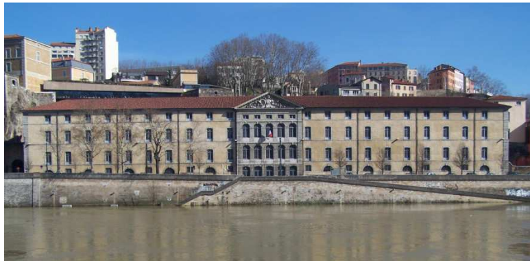
Fig. 1. Lyon. Le grenier d'abondance, façade ouest (photo. A. Nicolier)
