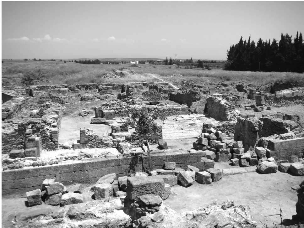
Figure 9. Vue de la Maison de Yabninou, depuis l'ouest vers l'est. Au premier plan, des blocs de pierre de taille éboulés conservés pour le projet de mise en valeur patrimoniale (© Mission de Ras Shamra, Y. Kanhoush).
