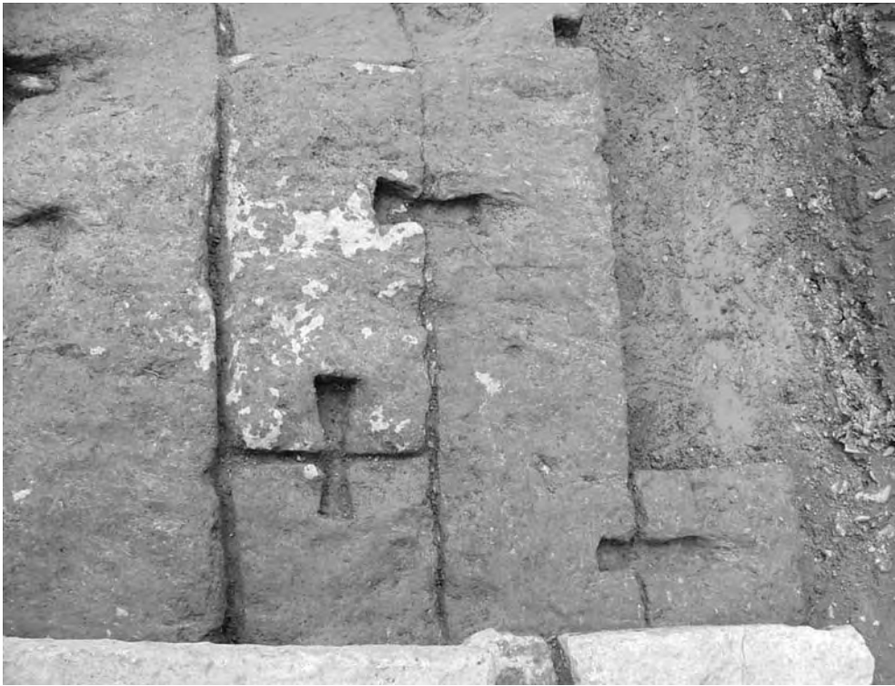
Fig. 30 – Cavités en forme de queue d'aronde, sur le dallage entre la pile et le massif d'ancrage (© Mission de Ras Shamra, cliché F. Onnis).
