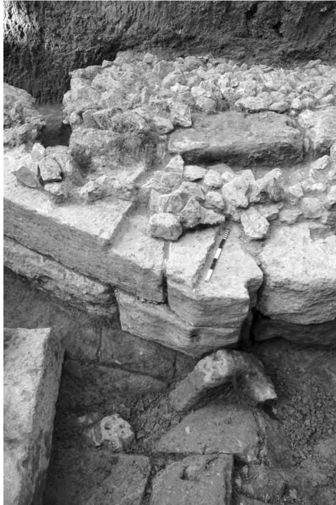
Fig. 25 – Les décrochements sur la surface de la deuxième assise du massif d’ancrage de rive gauche, avant enlèvement des moellons qui les masquent partiellement (© Mission de Ras Shamra).
