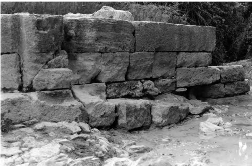
Fig. 31 – Vestiges du dallage dans la passe nord, tels que dégagés en 1992 (© Mission de Ras Shamra).
