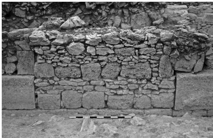
Figure 17 : Porte (3101) bouchée du bâtiment B du chantier « Grand-rue ».
