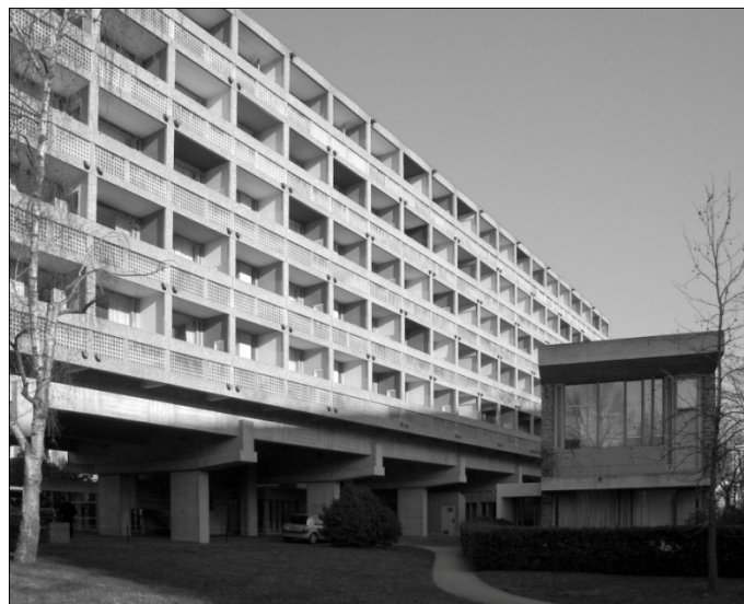
Figura 1. Casa de Brasil. Fachada sureste. Estado actual. 1
