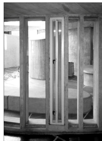
Figuras 4 y 5. Brise-soleil sureste y aérateur de planta baja. Estado actual.
