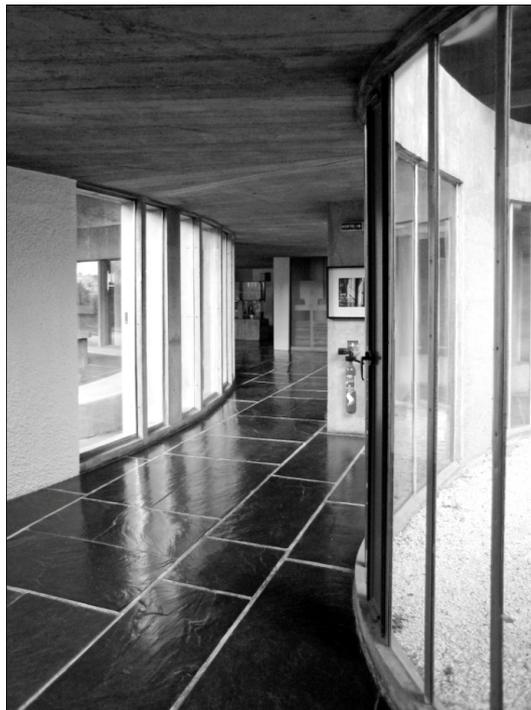
Figura 14. Dos *aerateur* de planta baja enfrentados en el *pan de verre ondulateur*. Estado actual.
