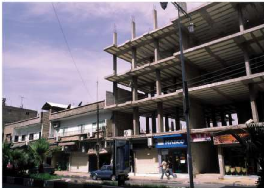
Figure n° 1 : La rue principale de Jeramana en 2008 : immeuble en construction à côté d'une des dernières habitations basses de la ville.
