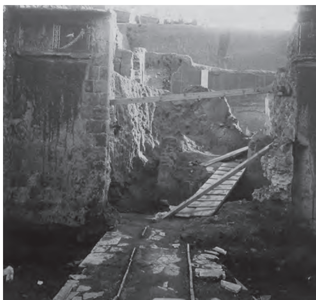
Fig. 22. La Casa a graticcio en cours de fouille après la destruction du mur oriental du nymphée de la Casa dello scheletro (AF-SANP(P), ex EC 18, daté de 1927).
