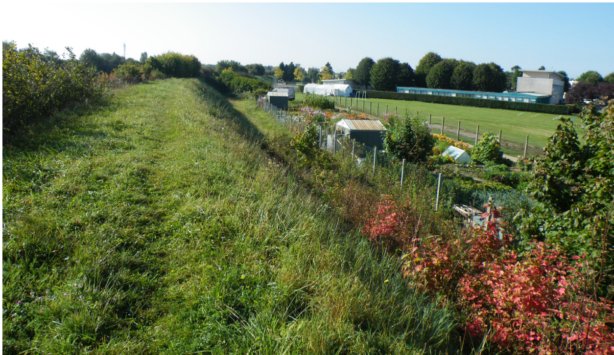
Chemin technique, menant vers un quartier projeté, jardins de la Mare aux Moutons (site 24b) en contrebas – source : Cerema, octobre 2014
