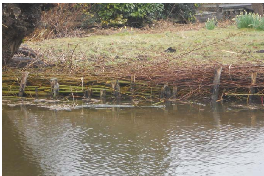
■ Fig. 148 : Exemple de berges aménagées à l'aide de poteaux, piquets et clayonnage.
