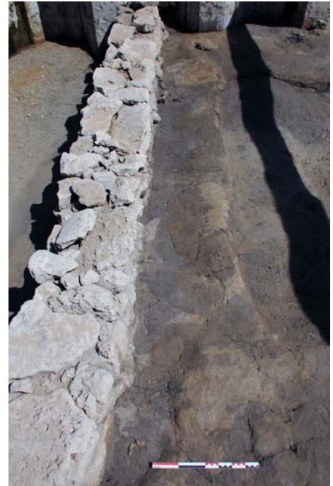
■ Fig. 88 : Vue depuis le sud de la banquette en bauge BQ69128 accolée au mur MR69044. La banquette révèle la mise en œuvre de terres de nature différente sous forme de mottes irrégulières.
