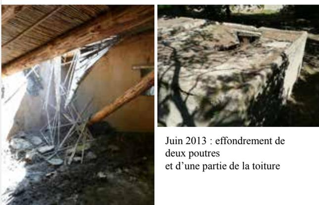
Juin 2013 : effondrement de deux poutres et d'une partie de la toiture
