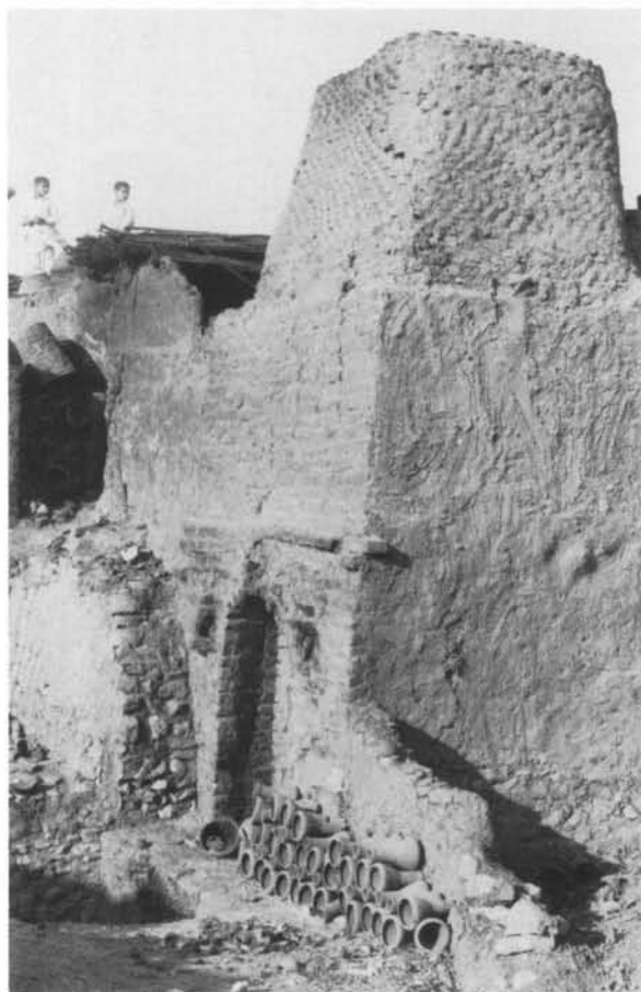
a — vue générale du four n° 12.
