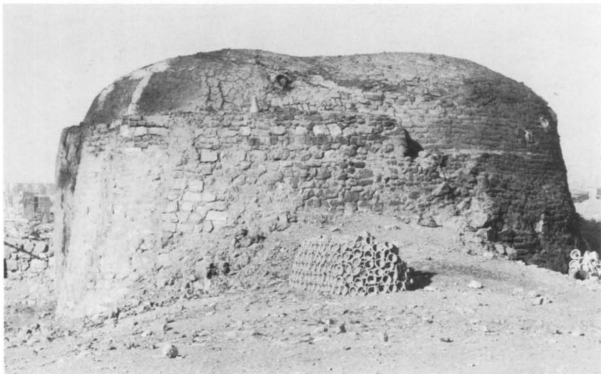
a — vue générale du four n° 1.
