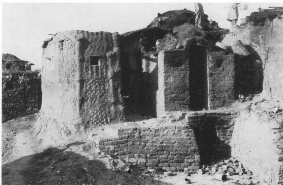
c — four n° 11 et entrepôt attenant.
