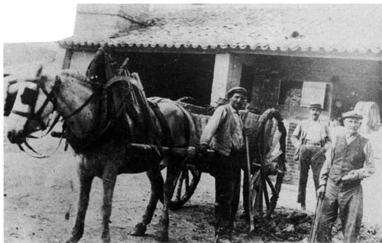
Exemple de témoin du passé artisanal
