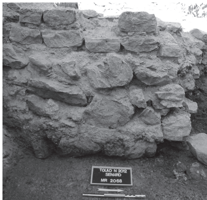
Fig. 15: le parement est du mur MR 2068 : détail de la maçonnerie, élévation et fondation (cliché B. Paris/CAV).
