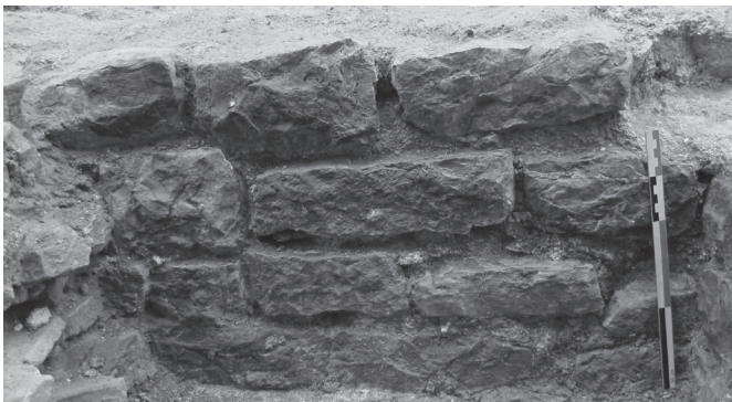
Fig. 13: le parement nord du mur MR 2067 : détail de la maçonnerie (cliché B. Paris/CAV).
