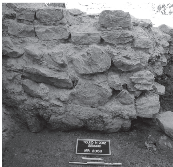
Fig. 15: le parement est du mur MR 2068 : détail de la maçonnerie, élévation et fondation (cliché B. Paris/CAV).
