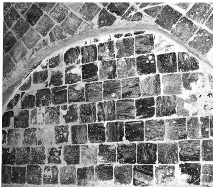
248 - Pavement de l'entrée de la chapelle.
