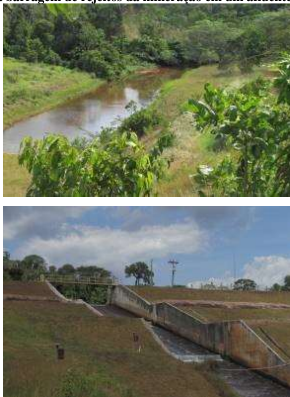
Figura 10 Áreas da barragem de rejeitos da mineração em um afluente do Igarapé Gelado.
