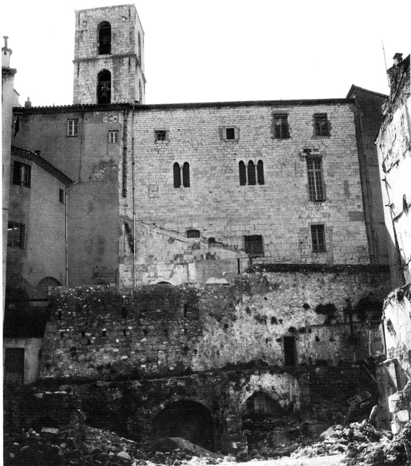
39. Façade nord du palais épiscopal de Grasse; les baies supérieures correspondent à un étage aménagé aux dépens de la grande salle (cliché Roucaute - Inventaire Général).
