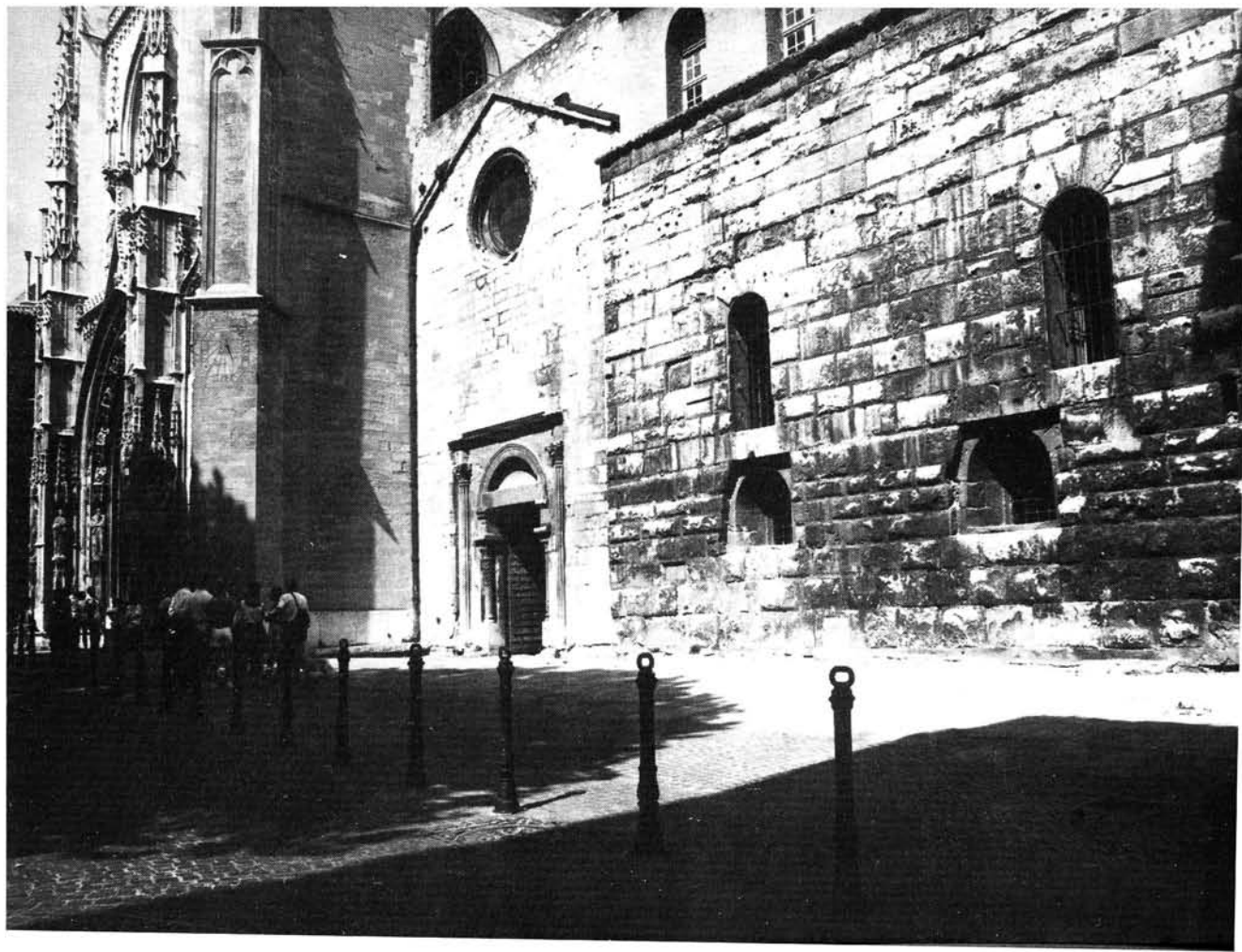
15. Le mur à bossages limitant à l'ouest les bâtiments canoniaux d'Aix-en-Provence. A l'arrière-plan, le portail de la nef Saint-Sauveur et de la nef Sainte-Marie (cliché Y. Rigoir).
