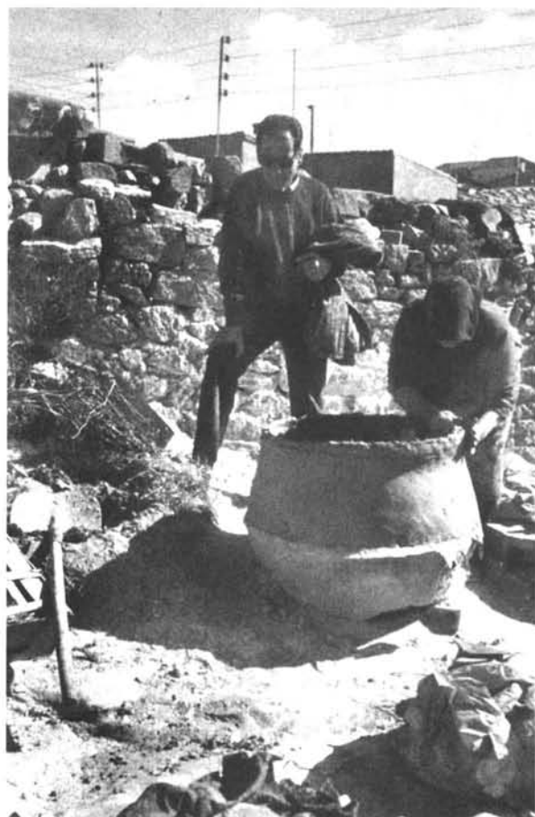
Fig. 2. Ángeles Redondo Martín modelant un four à pain sous l'œil de Miquel Bosch. En avant, la zone de préparation de l'argile au bas du tas d'argile forte (cliché M. Leenhardt).
