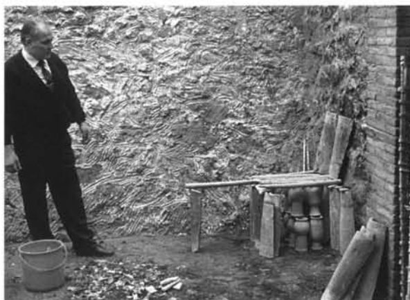
Fig. 36. Domingo Punter simulando la carga en échappade à l'aide de barres et de tuiles à Teruel (cliché J.T.).
