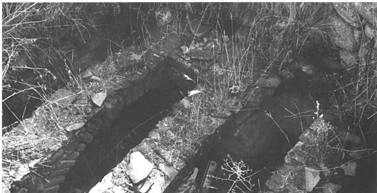
Fig. 32. Four « découvert » contemporain dont la sole est constituée de l'extrados des arcs transversaux, Carbelino de Sayago, région de Zamora (cliché J.T.)
