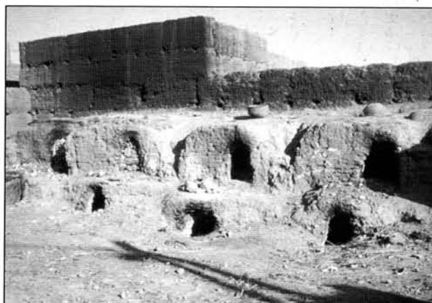
Figure 84 Batterie des fours de l'atelier coopératif de Tamegroute. Maroc, 1993. Le mode d'exploitation choisi peut modifier la structure traditionnelle des ateliers
