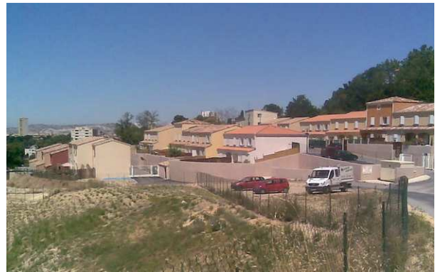
Entrée des résidences (chantier non terminé) - 2008
