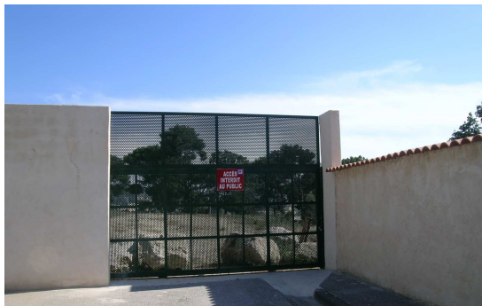
Photographie 3-17 : Fermeture de passage entre cité Air Bel et lotissement voisin
