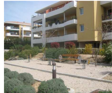
La Closeraie, jardin collectif interne à la résidence fermée
