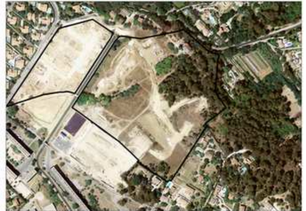
Le Domaine de la Ribassière en construction (2004)
