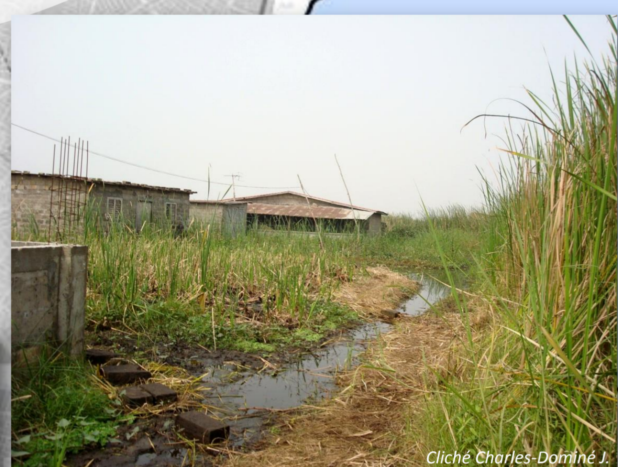
Construction anarchique dans les bas-fonds
