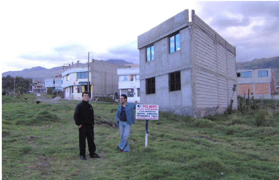
Figure 5 : L'application partielle des mesures de prévention par le propriétaire de la construction au premier plan. Il existe bien un mur aveugle... mais il ne s'agit pas de la façade directement exposée à la conduite de matières dangereuses, intégrée dans le réseau de transport des hydrocarbures de l'Equateur (Photo P Pigeon, El Beaterio , Quito, 2007).
