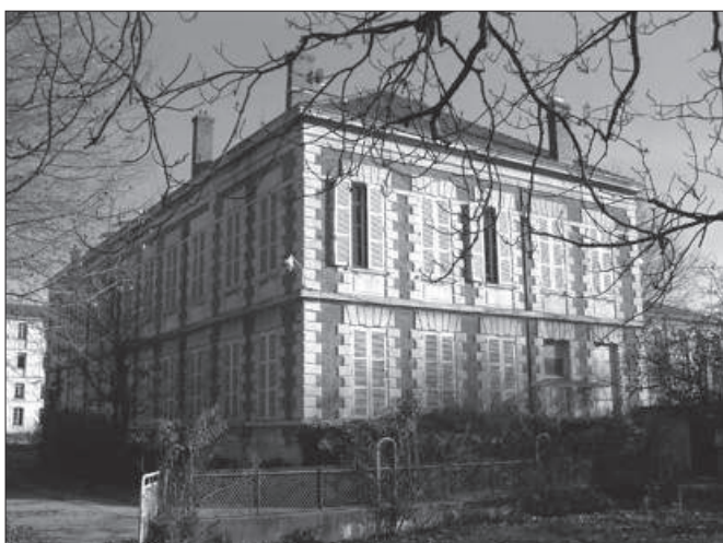
Photo 2 : Un bâtiment administratif détruit le 22 juin 2005
