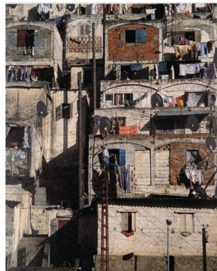
Djenan El Hassan, Alger, (Roland Simounet, architecte), en 1956 et aujourd'hui.
