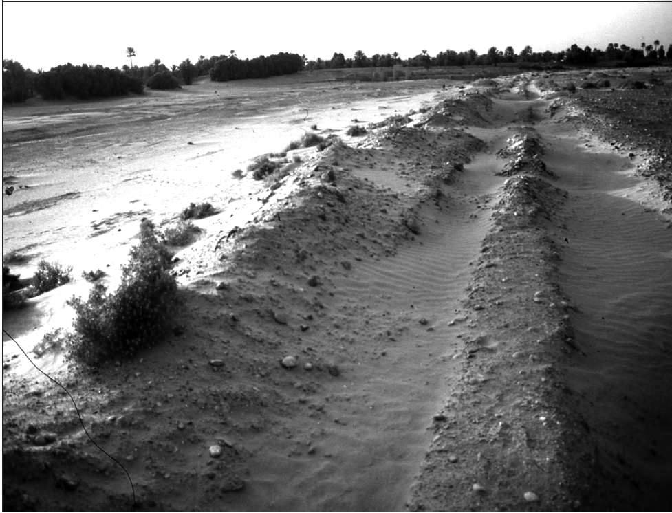
Figure 4: Dégagement superficiel de la ligne de digue d'origine midraride protégeant la ville de Sijilmāsa de l'oued Ziz (à gauche) réalisé par Lahcen Taouchikht en 1990 (cliché archives du MAPS – 1992)
