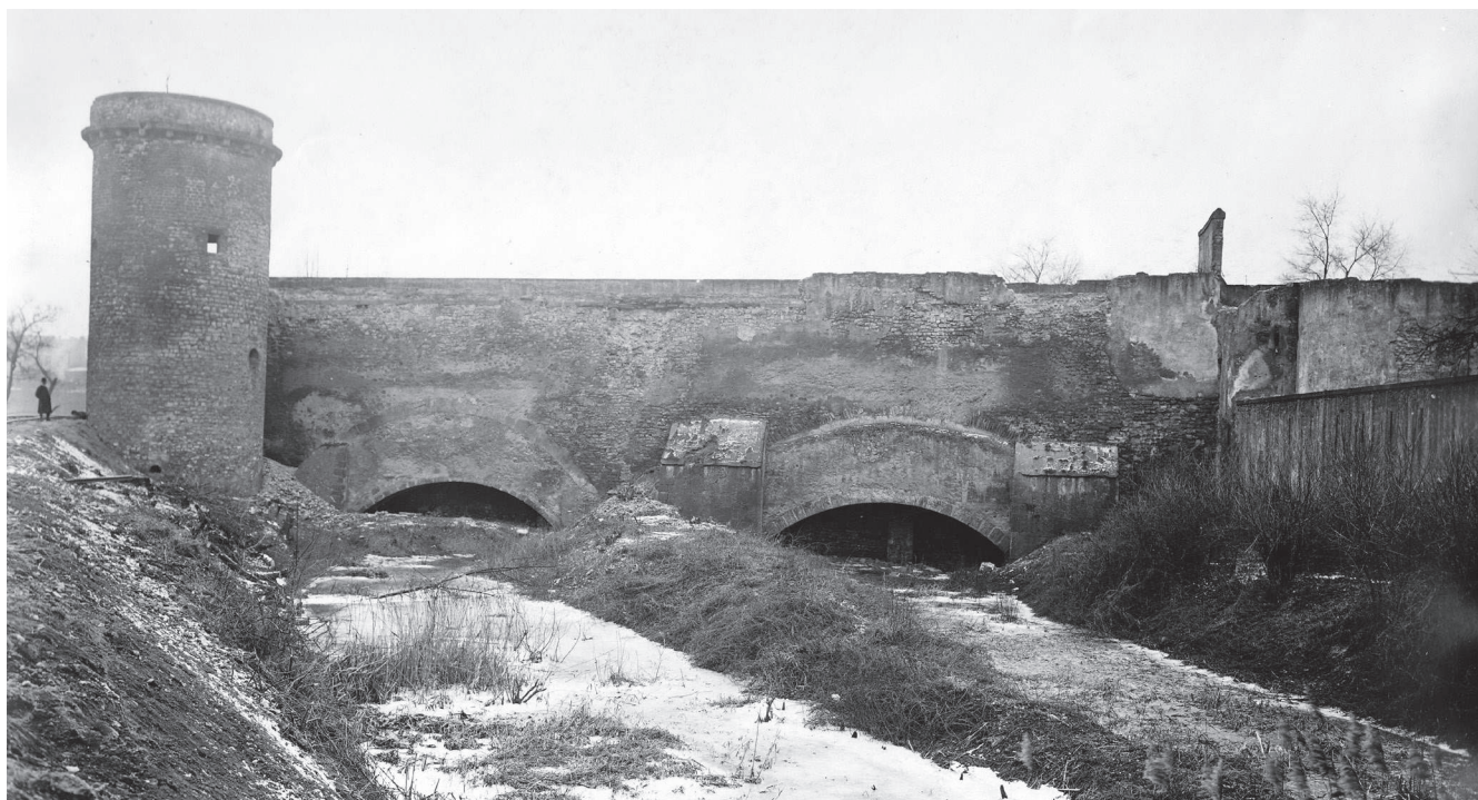
Fig. 11. Vue du pont des Grilles de la Basse-Seille depuis le nord-est en 1911 (© Musée de La Cour d'Or – Metz Métropole).
