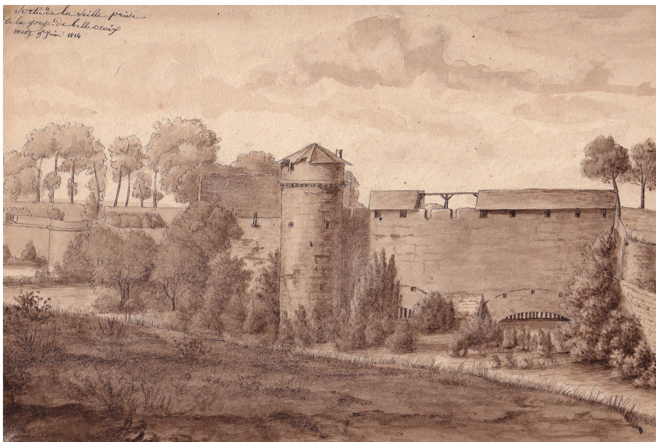
Fig. 10. Dessin anonyme du pont des Grilles de la Basse-Seille en 1814 vu depuis le nord-est. L'ouvrage est encore pourvu de sa toiture et de son crénelage (coll. particulière).
