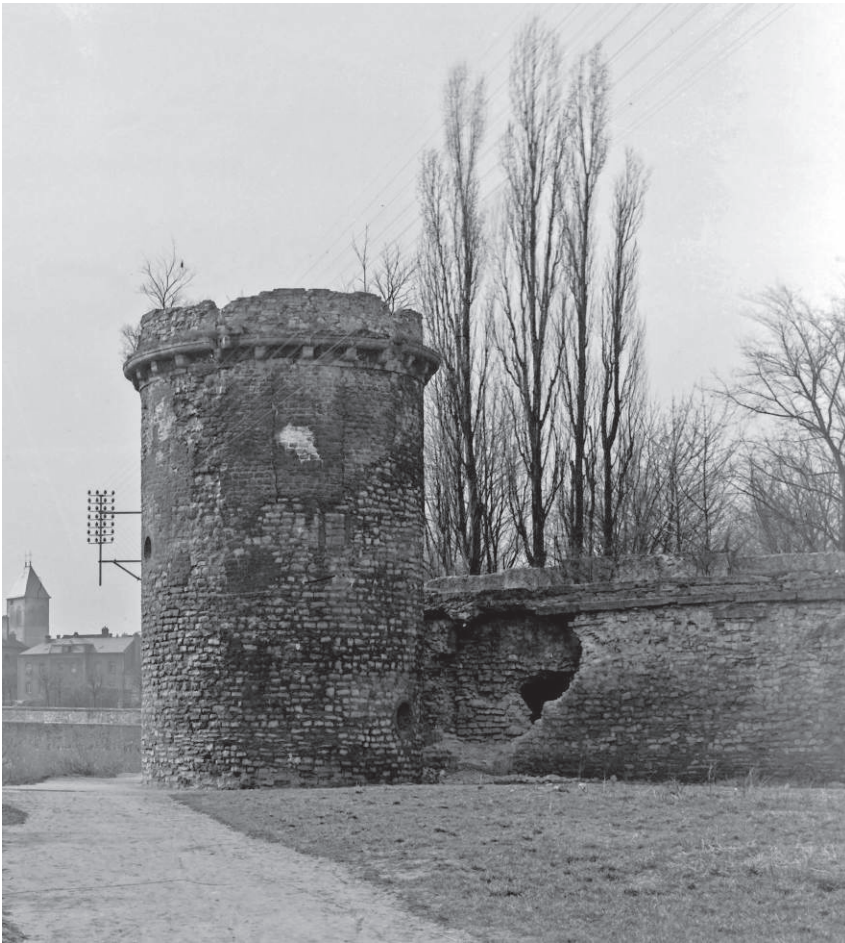
Fig. 16. Vue de la tour des Barbiers et des Chandeliers de cire et du pont des Grilles de la Basse-Seille à la fin des années 1920. L'ouvrage est remblayé, mais il est toujours pourvu de son mur extérieur (© Bibliothèques-Médiathèques de Metz).
