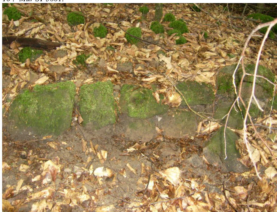
Cliché 11 : Détail du mur ST 3001.
