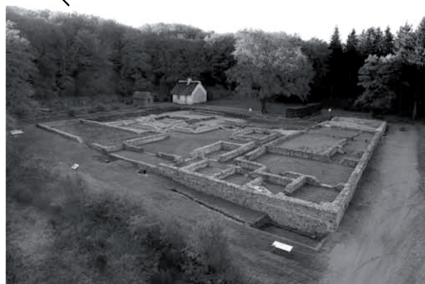
Bibracte, Mont Beuvray. Domus PC 1. Vue vers le sud de la domus à la fin de la campagne de fouille 2011 et des travaux de mise en valeur effectués par le chantier d'insertion géré par l'association Tremplin (cliché Bibracte/A. Maillier).
