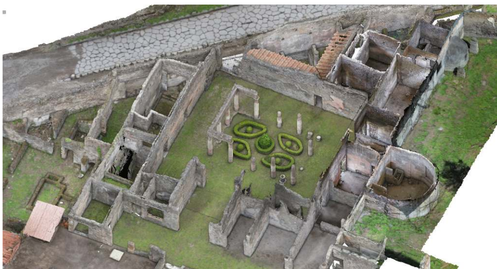
Fig. 3 – Modèle photogrammétrique du secteur d'étude, vu de l'ouest, état 2013.
