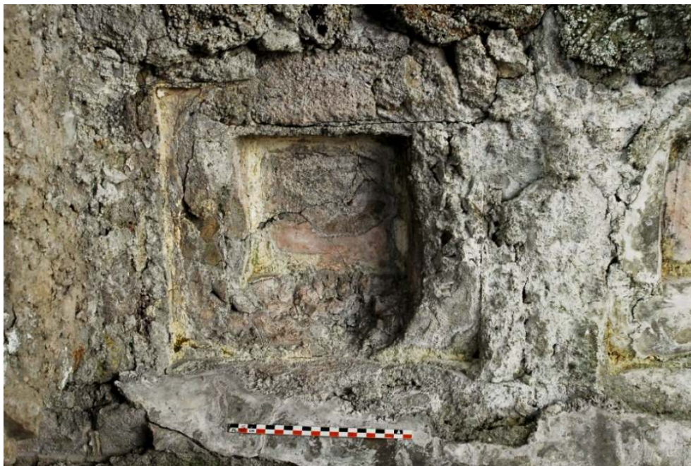
Fig. 11 – Pièce 45, détail du plafond à caissons à coffrage maçonné.
